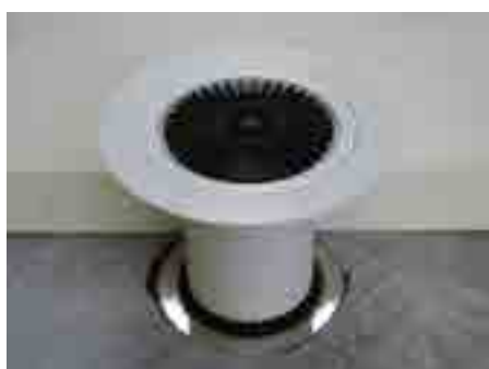
8. Укласти теплоізоляцію, підняти за висотою надставний елемент HL350.0
