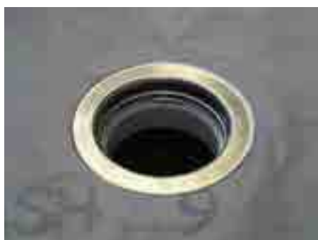
10. Затиснути фільтрувальний шар фіксувальним фланцем елемента HL350.0
