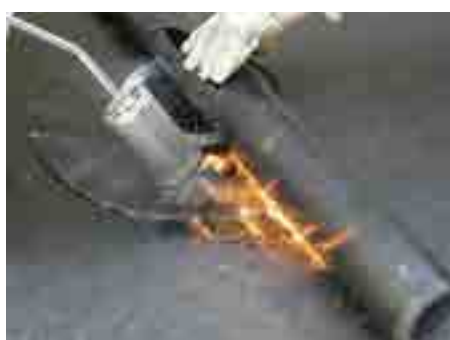
4. Наклеїти 2-й шар гідроізоляції (до обтискного фланця)
