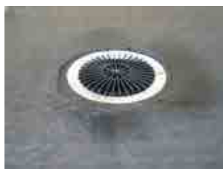
5. Такий вигляд має мати воронка після укладання гідроізоляції.
